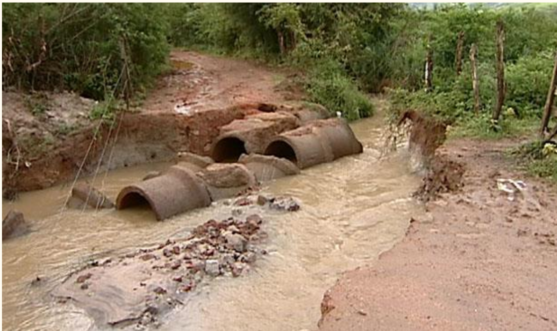
Imagem: Rompimento de manilha e estrada intransitável, em Moxuara
